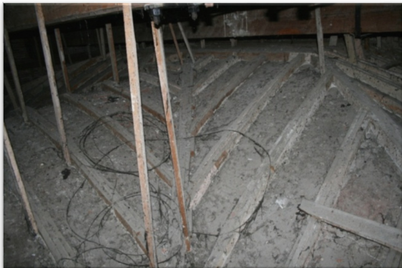
Capriate di sostegno della volta e degli appendini di legno di sostegno alle cantine
